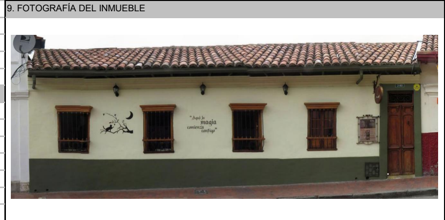
Fuente: Equipo Fotografía PEMP Patrimonio Inmueble
