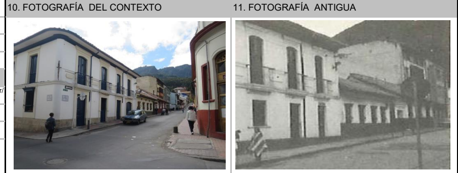
Fuente: Equipo Fotografía PEMP Patrimonio Inmueble
